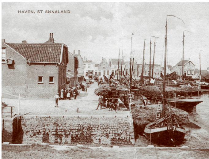
Links spuisluis die het water vanuit de achterliggende polders afvoerde en rechts is het uitgesleten geultje te zien dat ontstond bij het spuien (foto rond 1915-1920).
